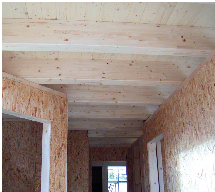
Die Symbiose aus Holz und Beton kombiniert die Vorteile beider Baustoffe. Zwei HBV-Bausysteme: Im linken Bild als vorgefertigtes Balkensystem mit eingeklebtem Schubverbinder, das auf der Baustelle verlegt und in den Feldern mit bspw. "Sicht"-Schalung geschlossen wird. Anschließend werden Baufolie und Bewehrungsmatte aufgelegt und der Beton eingebracht. Rechts: In eine Massivholzplatte aus BSH werden die Schubverbinder werkseitig eingeklebt und das Element mit einer Feuchtigkeitssperre versehen. Das fertige Bauteil wird per Kran verlegt und vergossen. (Fotos: TiComTec GmbH)
