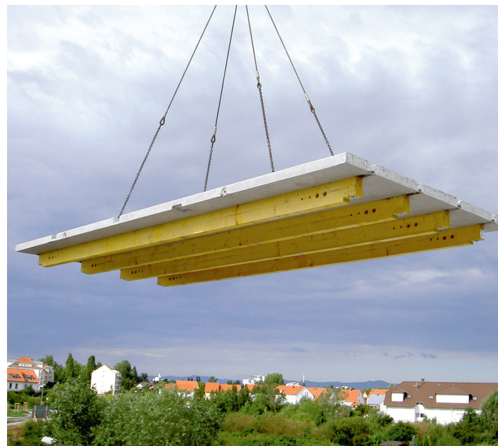
Die Symbiose aus Holz und Beton kombiniert die Vorteile beider Baustoffe. Zwei HBV-Bausysteme: Im linken Bild als vorgefertigtes Balkensystem mit eingeklebtem Schubverbinder, das auf der Baustelle verlegt und in den Feldern mit bspw. "Sicht"-Schalung geschlossen wird. Anschließend werden Baufolie und Bewehrungsmatte aufgelegt und der Beton eingebracht. Rechts: In eine Massivholzplatte aus BSH werden die Schubverbinder werkseitig eingeklebt und das Element mit einer Feuchtigkeitssperre versehen. Das fertige Bauteil wird per Kran verlegt und vergossen. (Fotos: TiComTec GmbH)
