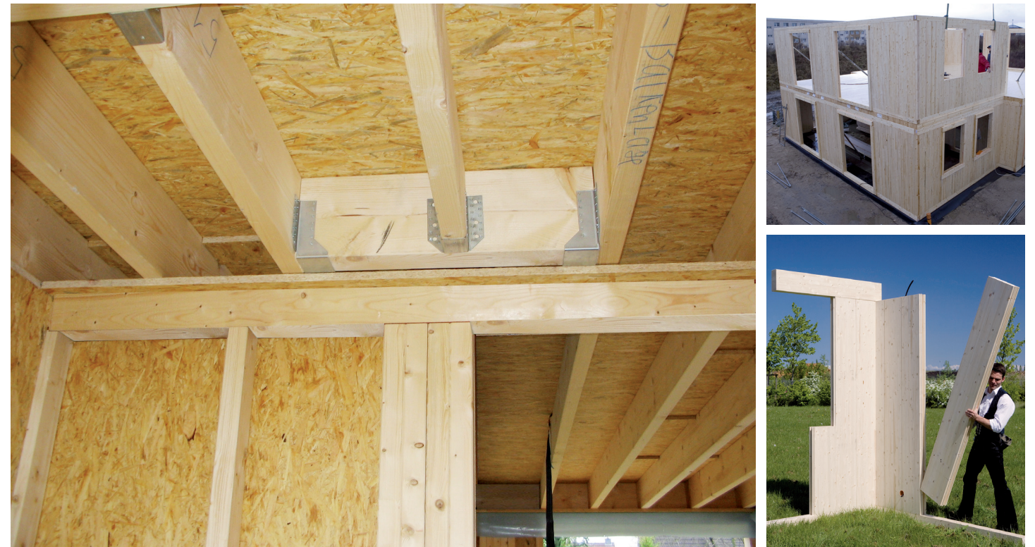
Kein Problem mit großen Lasten – mit wandintegrierten Verstärkungsstützen lassen sich auch außergewöhnliche Lasten sicher und nicht sichtbar abtragen (Foto: Technische Medien, Christian Meyer).
