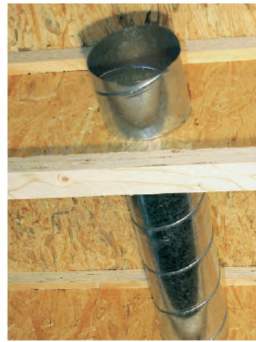
Oben: Keine zusätzliche Installationsebene erforderlich – Rohre und Leitungen werden durch den Steg geführt. Standardöffnungen sind nachweisfrei, größere Durchführungen können mit Hilfe der Herstellersoftware berechnet werden. (Foto: Metsä Wood)
