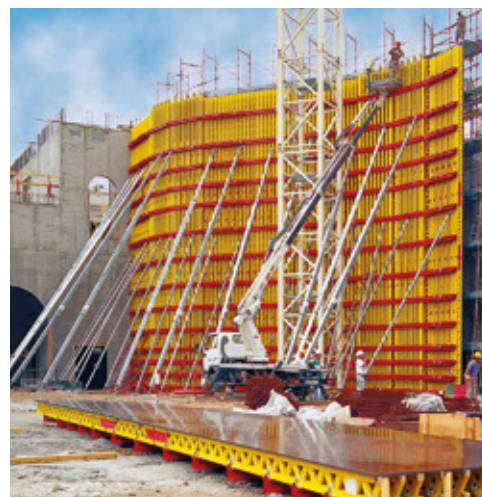
Schalungsplatten im grossflächigen Einsatz
