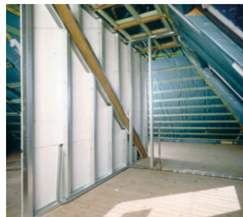
Wegen ihres geringen Gewichts, bei gleichzeitig hoher Funktionalität und Flexibilität spielt die Leichtbauweise eine große Rolle für Sanierung und Modernisierung (hier: Ständerwerk beim Dachausbau mit einer Gipsfaserbeplankung).
