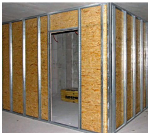
Standardaufbau einer Leichtbauwand mit einer Beplankung aus OSB-Platten
