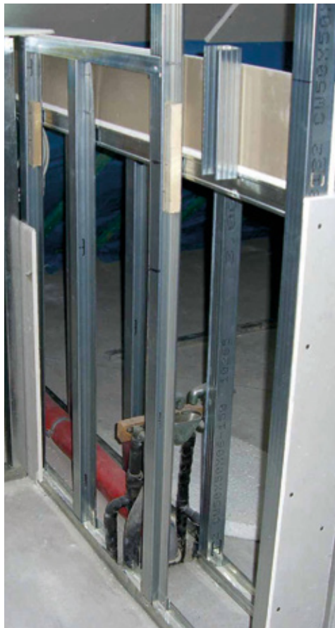
Oben: UA-Aussteifungsprofil für den Türeinbau Rechts: Traversen, wie sie für die Aufnahme von WC/ Waschtisch verwendet werden
