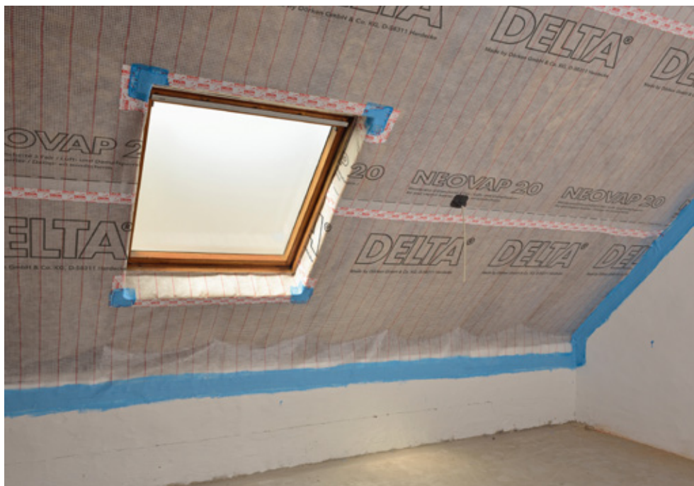
Luftdicht angeschlossene Dichtbahnen stellen den Feuchte- und Wärmeschutz sicher.
