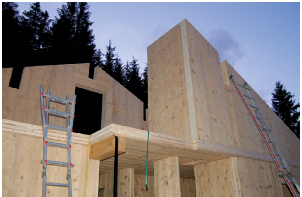
Mit BSP-Bauteilen können Wände, Decken und Dächer hergestellt werden.
