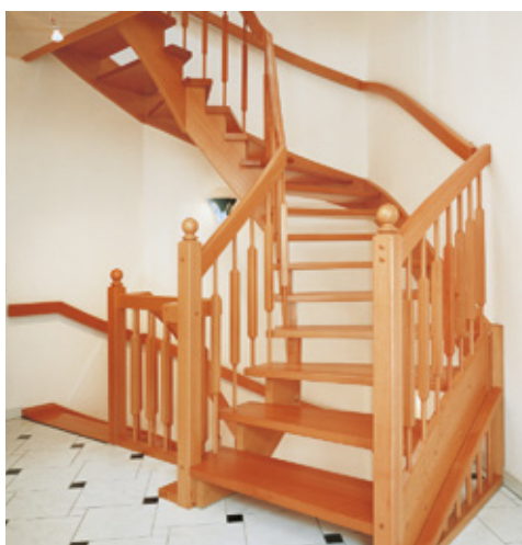
Eingestemmte, aufgesattelte Treppe mit Geländer
