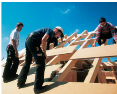
Unterdeckplatte als Dämmung über dem Sparren
