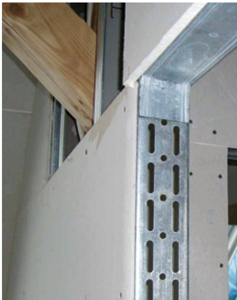
Oben: UA-Aussteifungsprofil für den Türeinbau Rechts: Traversen, wie sie für die Aufnahme von WC/ Waschtisch verwendet werden
