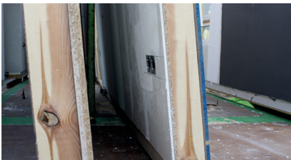
Vorgefertigte Holztafelelemente mit Spanplatten
