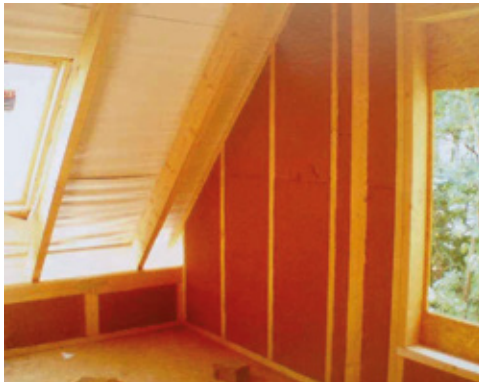
Dämmung beim Dachausbau
