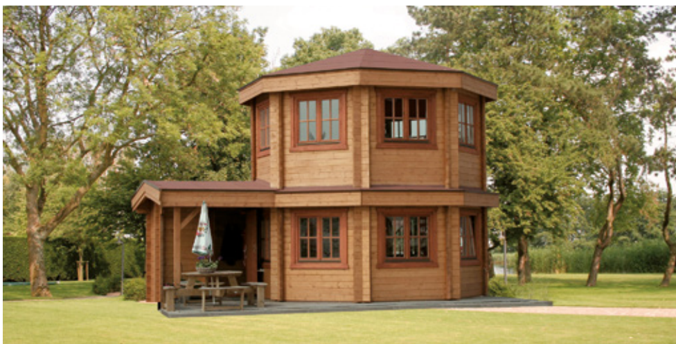
Pavillon mit Obergeschoss, farbbehandelt
