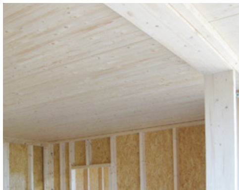
Mit Wand-, Dach- und Deckenelementen aus BS-Holz lässt sich der komplette Rohbau erstellen.
