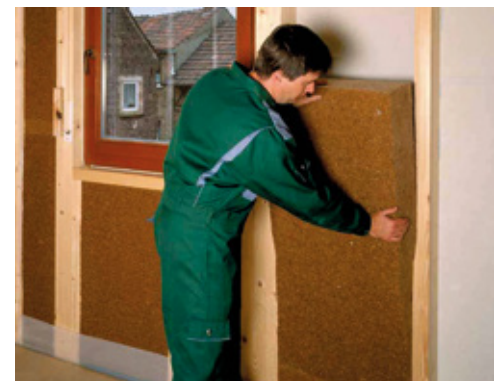
Montage von Holzfaserdämmplatten
