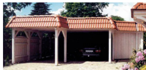
Carport-Anlage mit doppelreihiger Pfannenwalmdachblende
