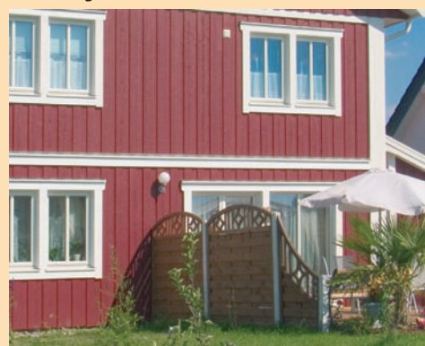
Abb. 65: Die Boden-Deckel-Schalung, Vertikalschalung in der größeren Struktur
