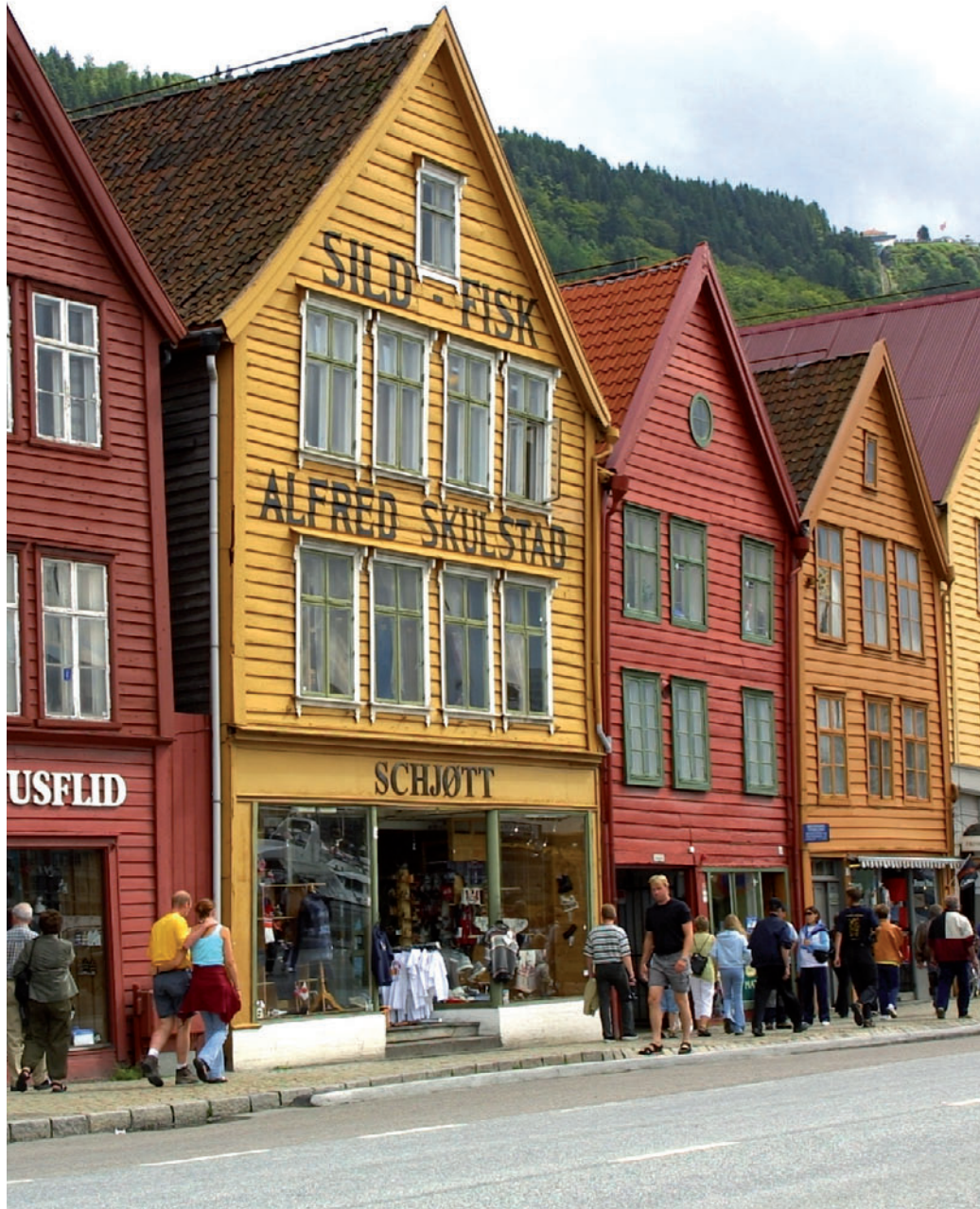
Abb. 61: Holzfassaden trotz der Witterung. Hier als Beispiel: Bergen in Norwegen ist die Stadt mit der höchsten Niederschlagsquote in Europa und dies bei hoher Windbeanspruchung und salzhaltiger Luft. Hier haben sich Holzfassaden als bestes System durchgesetzt und haben eine lange Tradition. Die Beschichtungen sind hochwertig und werden gut gepflegt.
