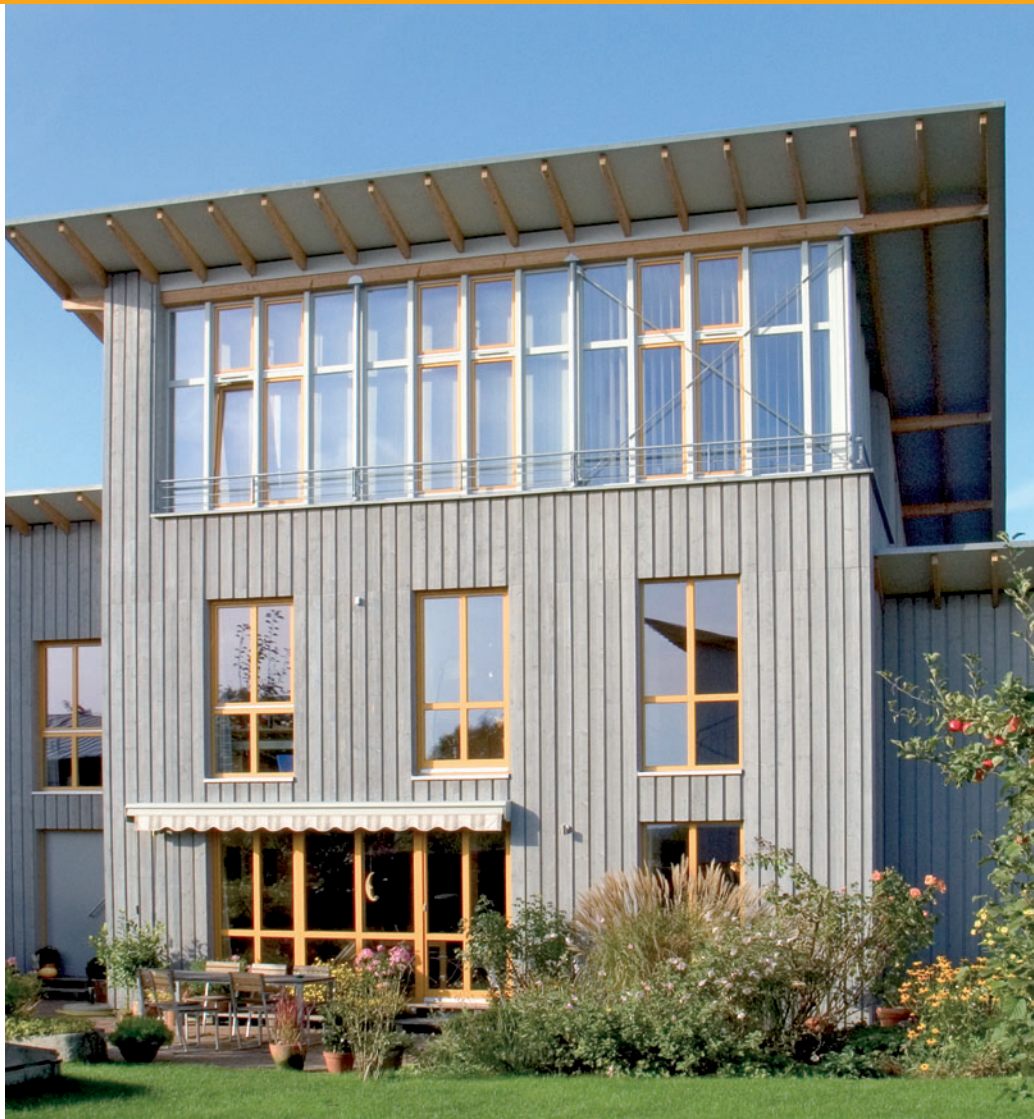
Abb. 2: Robuste Holzfassade – Vertikalschalung als Boden-Deckel-Schalung
