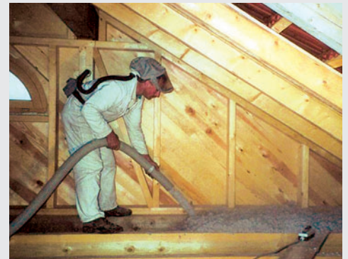
Abb. 22: „Aufblasen“ von Cellulose – hierdurch entfällt der Zuschnitt von Plattendämmstoffen.
