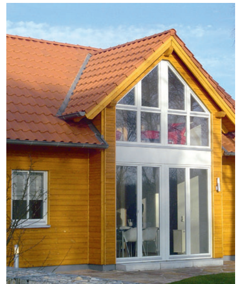
Abb. 4: In den nordischen Ländern das prägende Bild an Wohngebäuden: Eine zeitlose Gebäudegestaltung in verschiedenster Farbgestaltung, hier eine Horizontalschalung mit Stülpp-Profil
