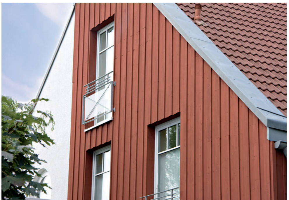
Abb. 37: Auch im Bereich der Fenster wird das Prinzip der Hinterlüftung beibehalten
