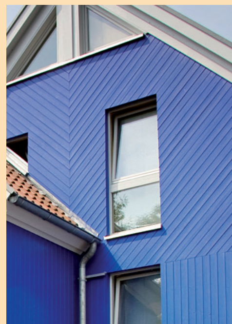
Abb. 86: Im Neubauzustand sieht es noch gut aus. Die Kontaktstöße werden hier allerdings zu Schäden führen.
