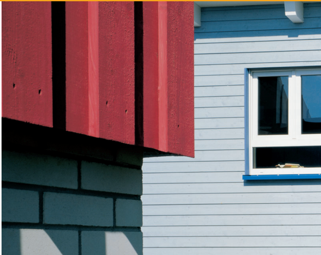
Abb. 41: Die Abtropfkante ist ein wichtiger Teil des konstruktiven Holzschutzes
