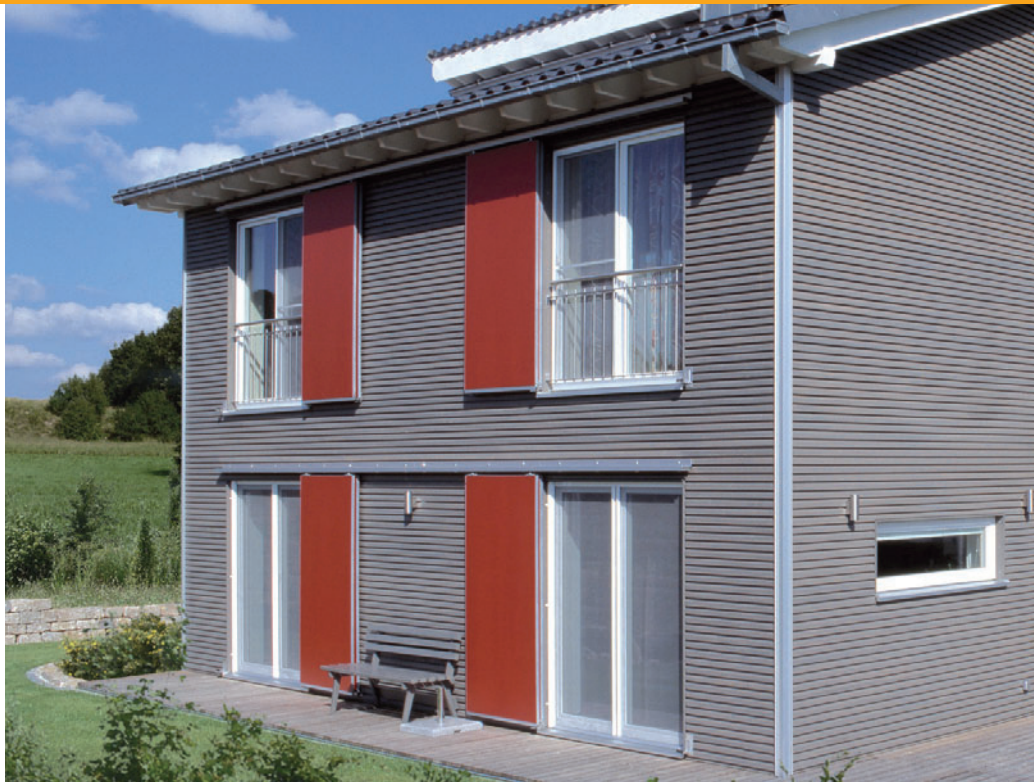
Abb. 47: Schiebeläden sind die moderne Antwort auf die traditionellen Klappläden
