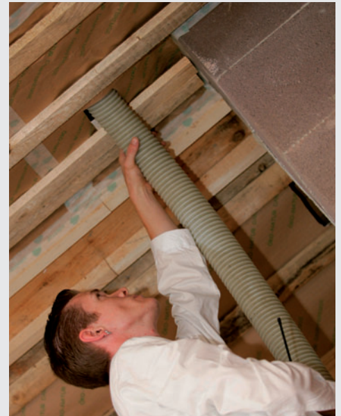
Abb. 21: Technisch und ökologisch überzeugend: Durch das Einblasen von Cellulose werden die Hohlräume vollständig mit Dämmstoff ausgefüllt.
