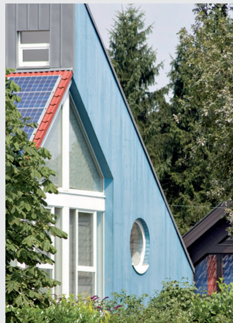
Abb. 29: Übergänge an der Fassade sorgfältig geplant und ausgeführt. So bleibt die Fassade ein „Hingucker“.
