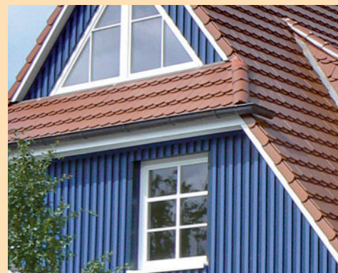
Abb. 64: Boden-Leisten-Schalung – nur ein Verbindungsmittel in der Deckleiste bleibt sichtbar
