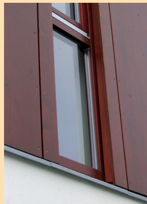
Abb. 85: Die vertikalen und horizontalen Fugen müssen offen sein.
