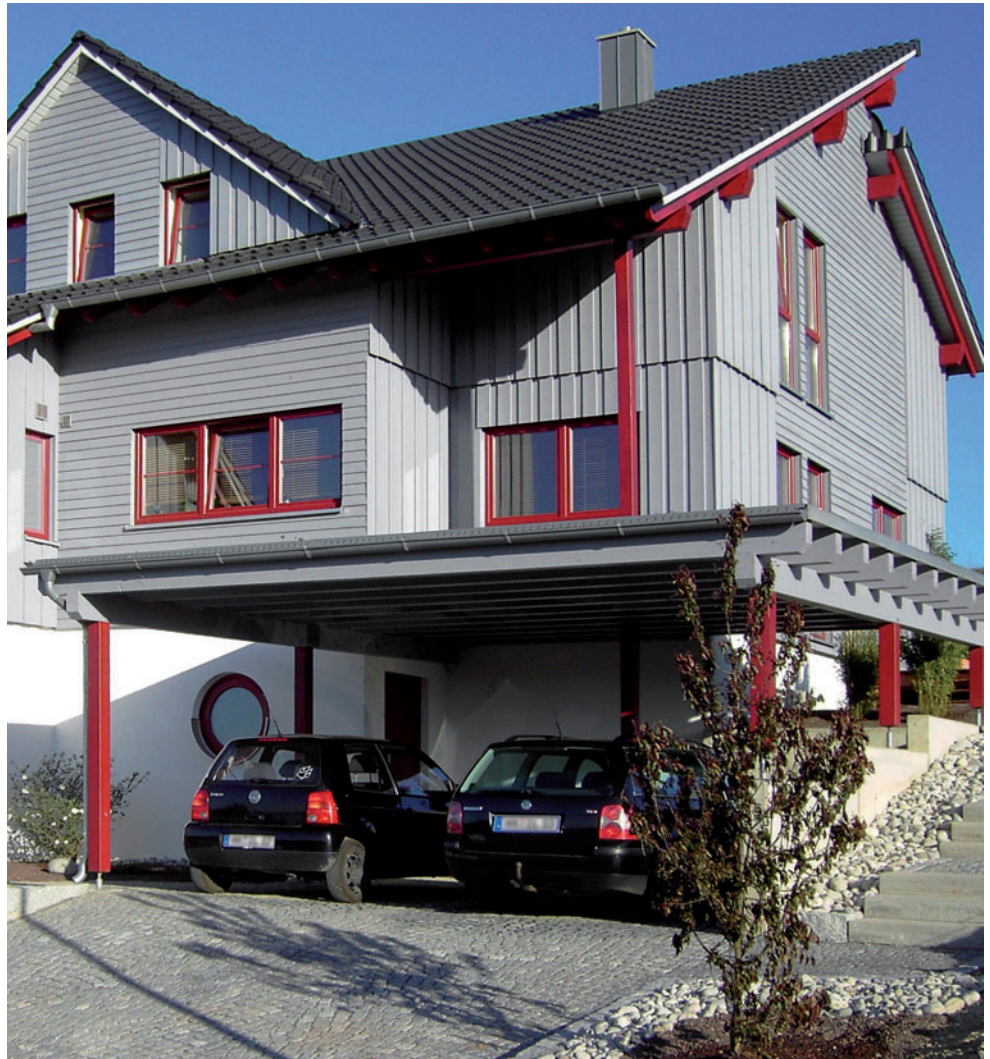
Abb. 82: Der Übergang vom Erdreich zur aufgehenden Wand (der Sockel) ist sorgfältig zu planen. Die Dauerhaftigkeit wird wesentlich beeinflusst. Dies gilt für alle Fassadentypen.
