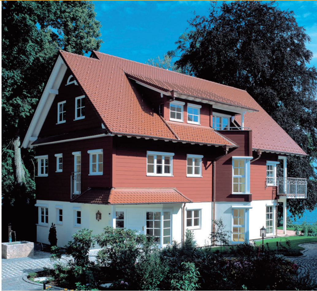
Abb. 44: Fenster prägen das Bild. Der aufgesetzte Außenrollladen ist energetisch sinnvoll und hier perfekt in der Holzfassade integriert.
