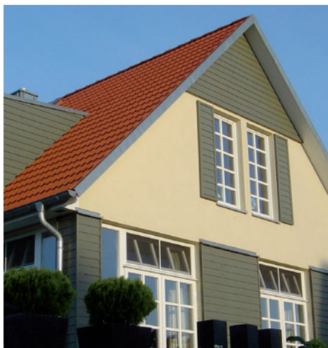
Abb. 52: Fensterläden, hier als dekoratives Gestaltungselement
