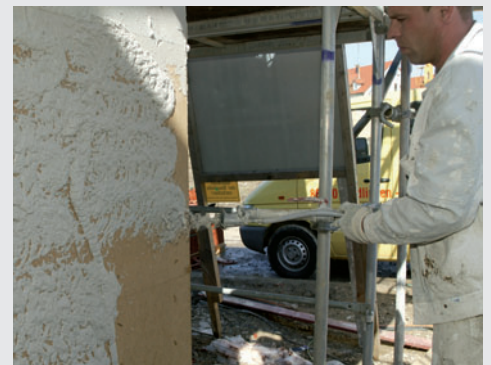
Abb. 23: Holzfaserdämmplatten, Aufbringen der Putzschicht
