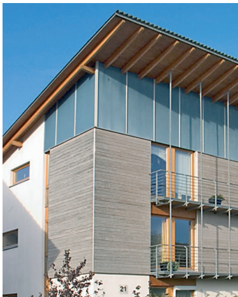
Abb. 3: In Deutschland der „Newcomer“, in der Schweiz längst bewährt – Horizontalschalung mit Rhombus-Profilen
