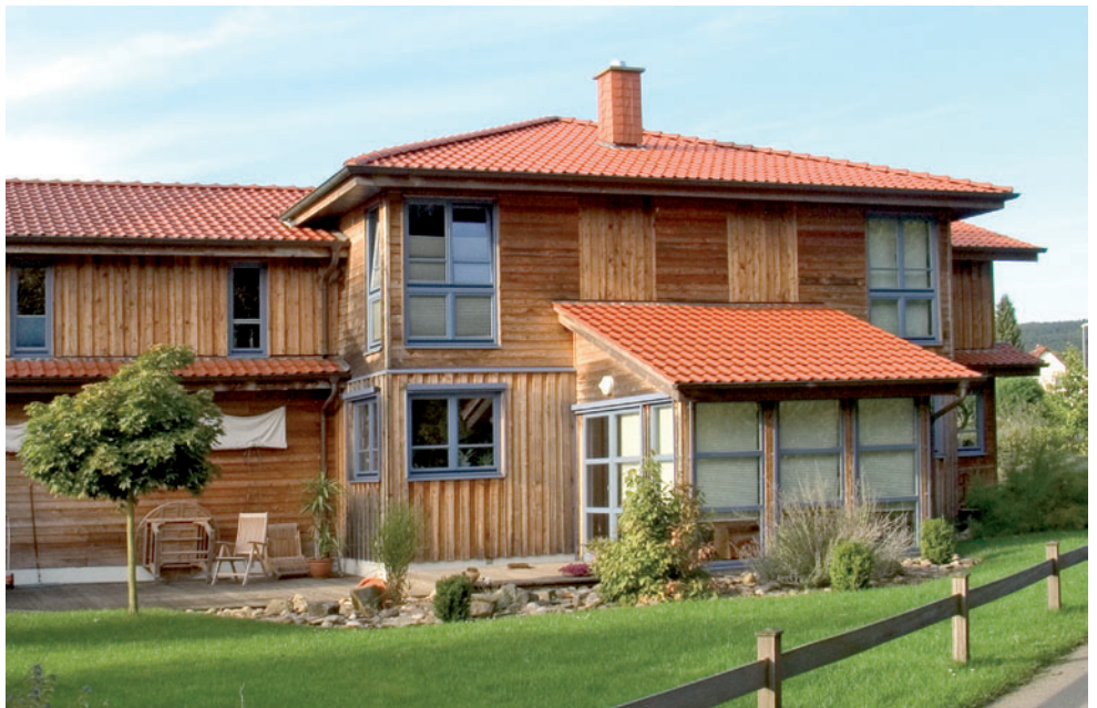
Abb. 15: Unbehandelte Holzfassade als Deckel-Boden-Schalung. Nach weniger als 2 Jahren ist die natürliche Patina (Vergrauung) bereits erkennbar. Aber Vorsicht: Nicht an jedem Standort sind unbehandelte Holzfassaden ohne Einschränkung zu empfehlen!
