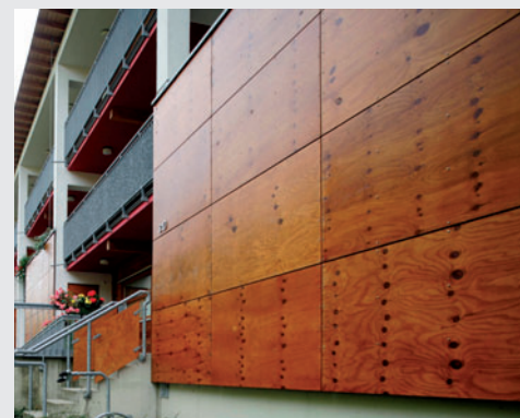
Abb. 72: Das Rohformat der Holzwerkstoffplatte prägt die Gliederung des Gebäudes ...
