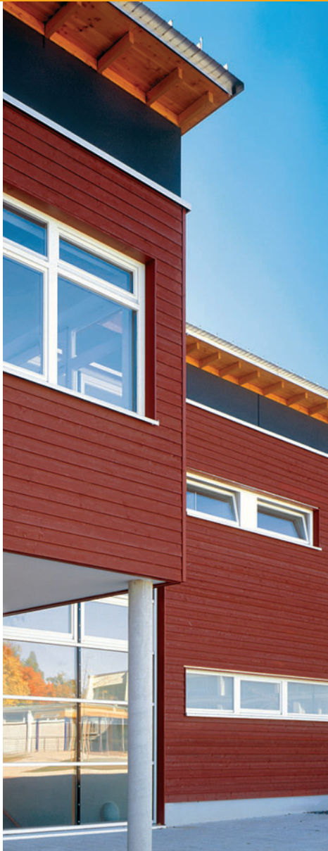
Abb. 32: Schulgebäude, heute mit attraktiver Gestaltung – endlich!
