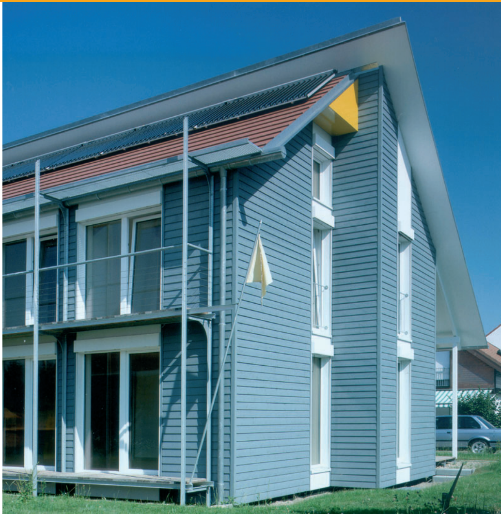
Abb. 36: Die Stülpschalung ist hinterlüftet, damit bleibt die dämmende Rohbauwand permanent trocken.
