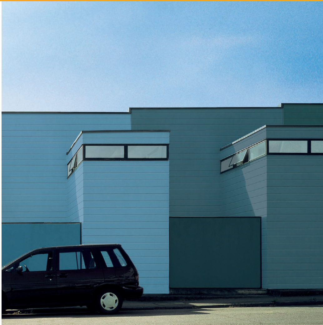
Abb. 78: Modernes Gebäude gestaltet mit Fassadenpaneele aus WPC
