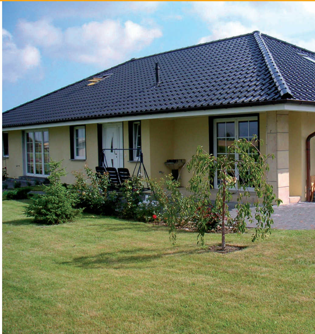
Abb. 24: Ältere Holz-Fertighäuser lassen sich mit einer energetischen Modernisierung von außen sehr gut auf „Neubaustandard“ bringen.
