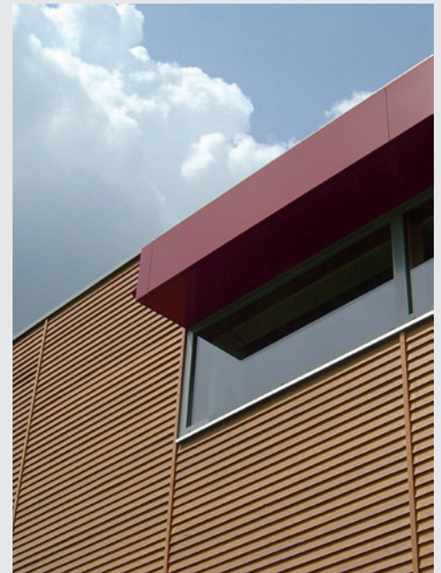
Abb. 83: Gemäß den Landesbauordnungen dürfen Holzfassaden nur bei Gebäuden geringer Höhe verwendet werden.
