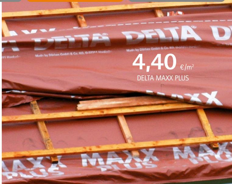
DELTA MAXX-PLUS, diffusionsoffene, winddichte Unterdeckbahn für vollgedämmte Steildächer mit integriertem Selbstkleberand
