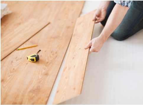
Verlegeservice Pünktliche und passgenaue Verlegung
