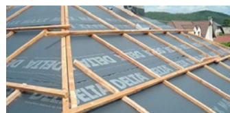
DELTA MAXX-PLUS, diffusionsoffene, winddichte Unterdeckbahn für vollgedämmte Steildächer mit integriertem Selbstkleberand
