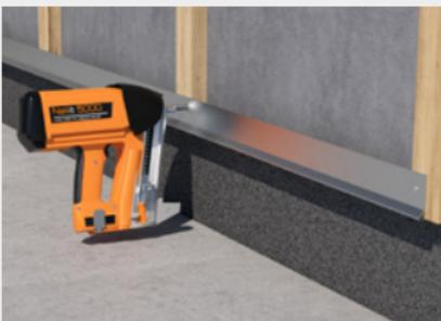
Befestigung des Sockel-Lüftungsprofil.
