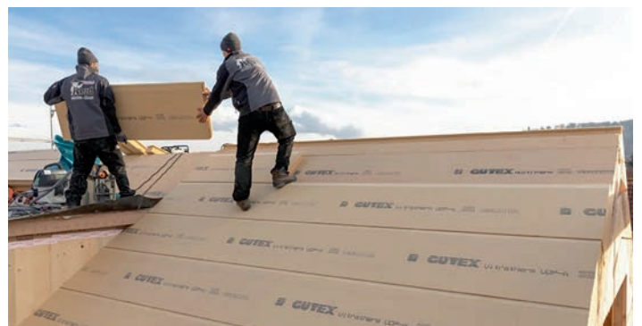
Bild: GUTEX Holzfaserplattenwerk
