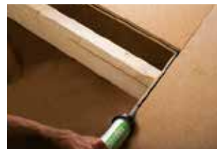
Abb. 9 Verkleben der Plattenstöße
