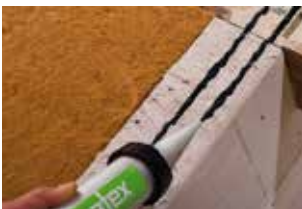
Abb. 8 Verkleben Anschlüsse und Bahnen
